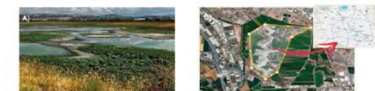
Fig. 1. Presa ambiental Presa Blanca. A) Fotografía del estado actual de Presa Blanca, B) Ubicación de la presa en el municipio de León.
