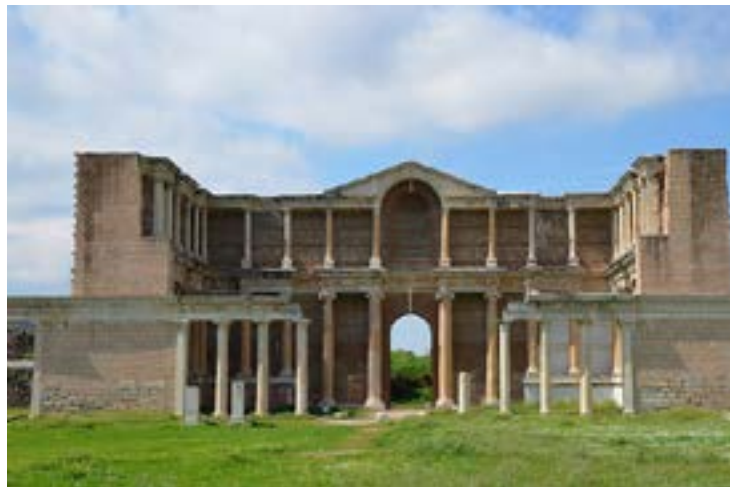
Figura 7 Complejo de baños-gimnasio en Sardis
